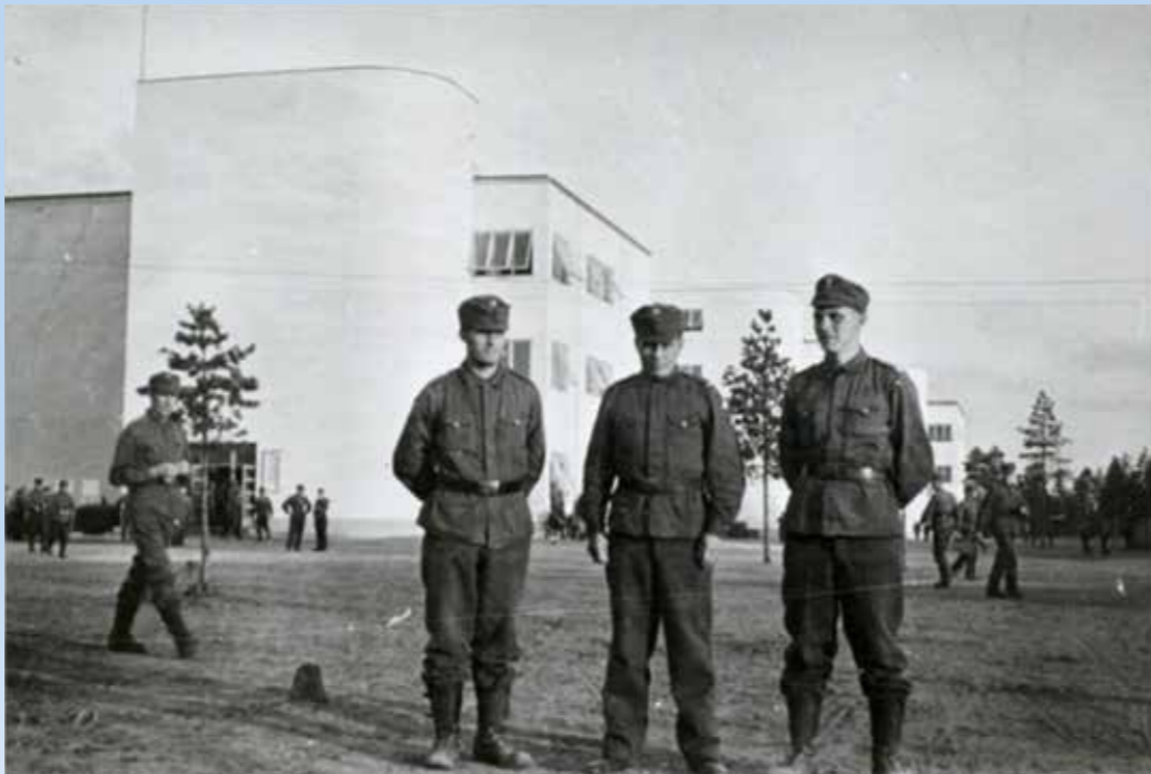
Reserviläisiä Niinisalon kertausharjoituskeskuksen päärakennuksen edessä vuonna 1934. Kuva: Museovirasto
